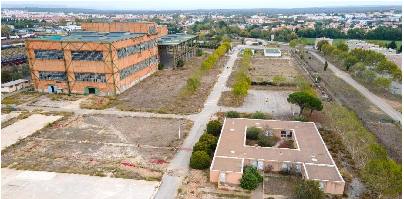
Vue du site d'implantation de CARBON à Istres © CARBON
